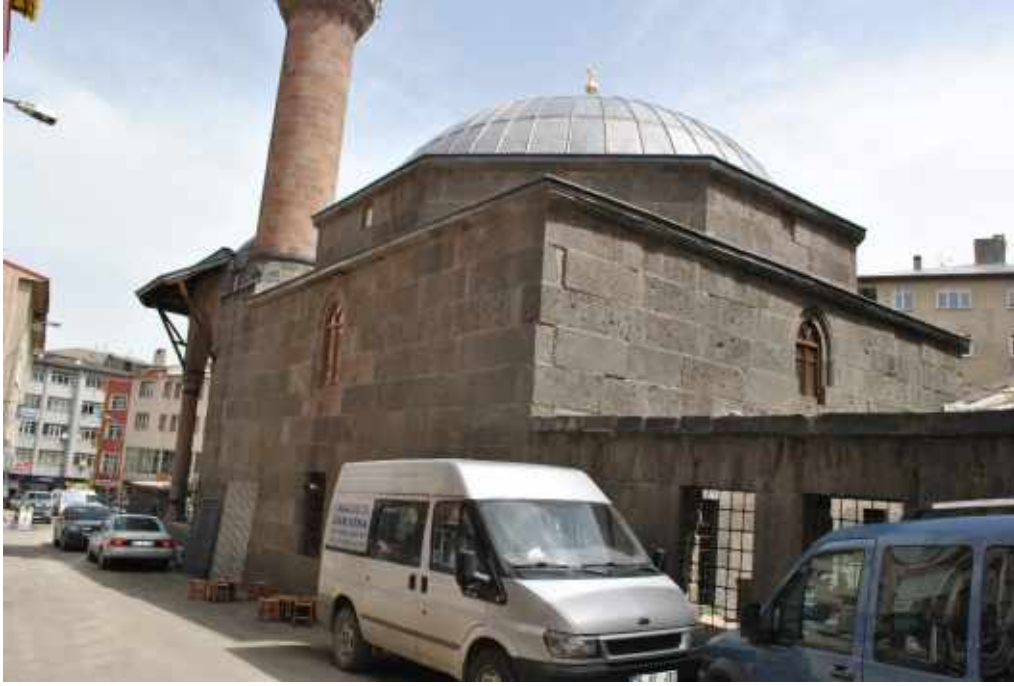
Resim 4: Bakırcı Camii batı ve güney cepheler (Atak, 2012)
