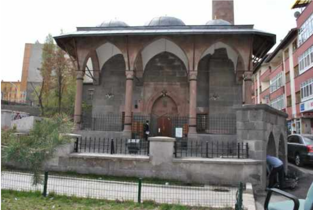
Resim 1: Bakırcı Camii kuzey cephe (Atak, 2012)
