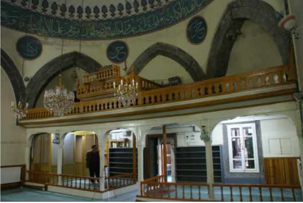
Resim 11: Bakırcı Camii kadınlar mahfili restorasyon öncesi (Vakıflar Genel Müdürlüğü Arşivi)
