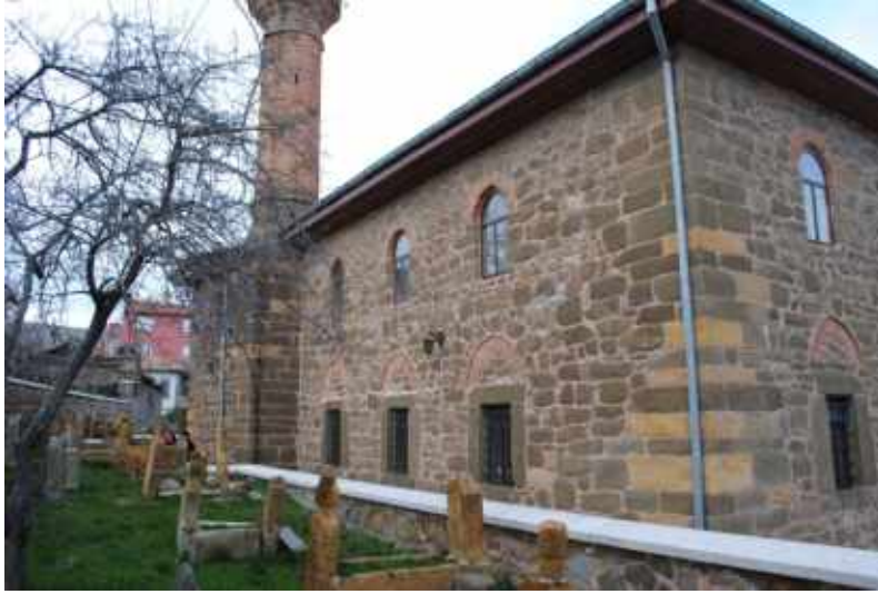
Fotoğraf 6: Yapının batı cephe görünüşü.
