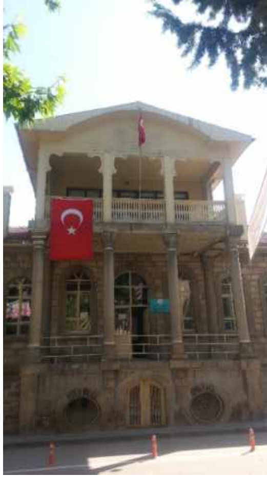
Resim 6: Güney Cephe Ana Giriş (Duymaz, 2017)
