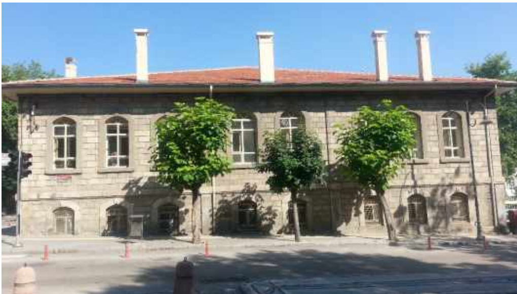
Resim 7: Batı Cephe (Duymaz, 2017)
