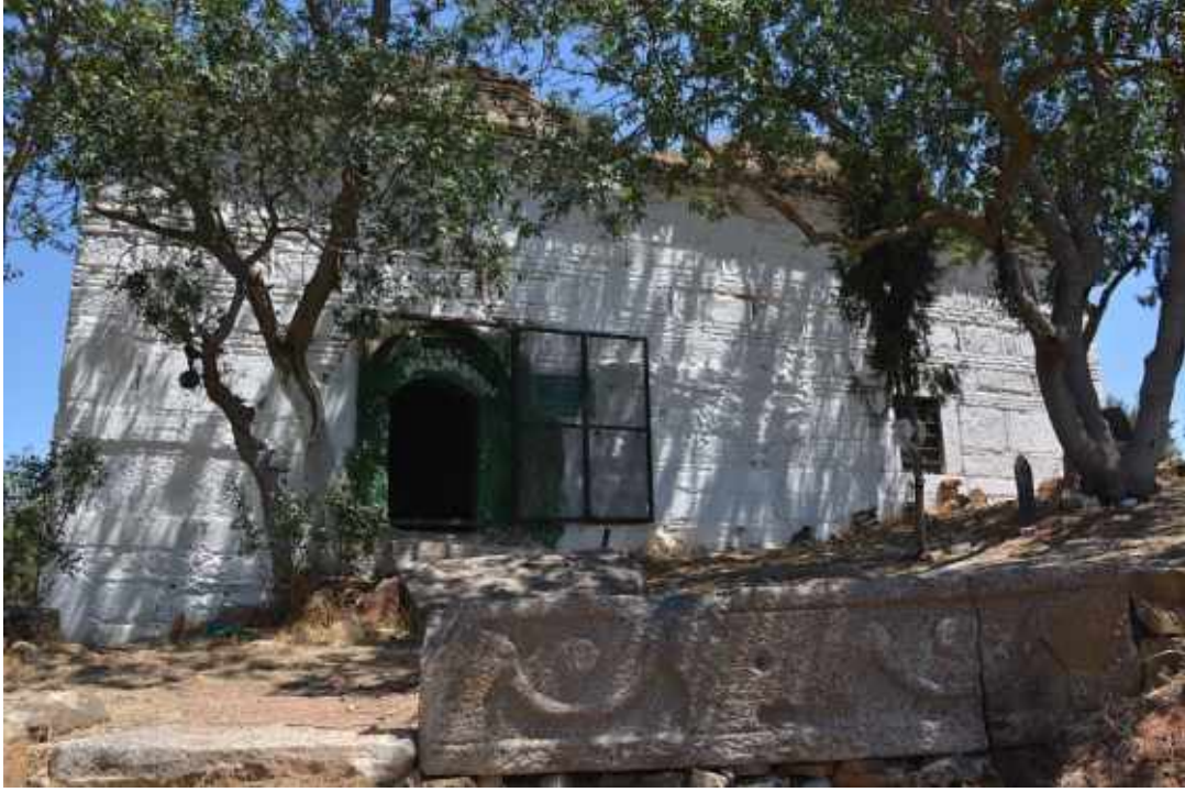
Resim 1-Sarı Dede Türbesi. Batı cephesi.
