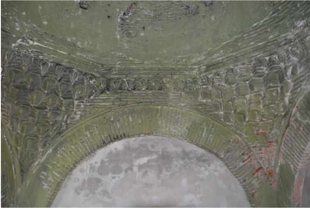
Resim 15-Sarı Dede Türbesi. Kubbe geçişlerinden.
