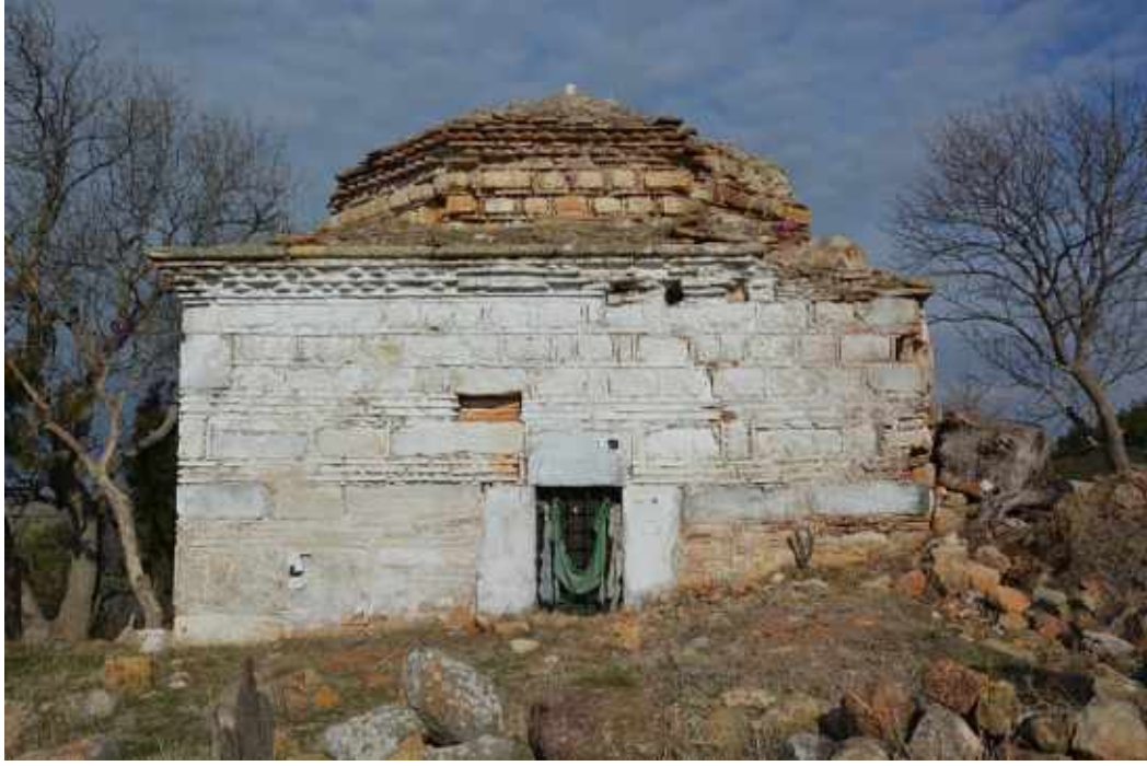
Resim 6-Sarı Dede Türbesi. Güney cephesi.
