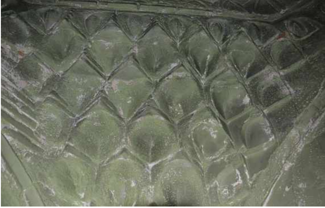
Resim 16-Sarı Dede Türbesi. Kubbe geçişlerinden ayrıntı.
