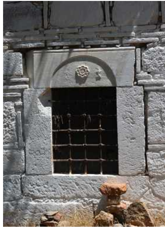
Resim 3-Sarı Dede Türbesi. Batı cephesindeki pencere.
