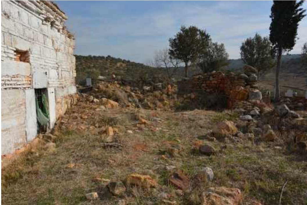
Resim 7-Sarı Dede Türbesi. Güneydeki yapı kalıntısı.
