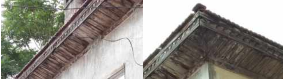
Resim 26. Ahşap Saçaklar ve Üçgen Motifleri
