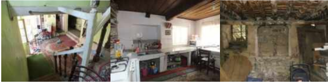
Resim 9. Sırasıyla Z01, Z02 ve Z03 Mekânlarından Görünüm
