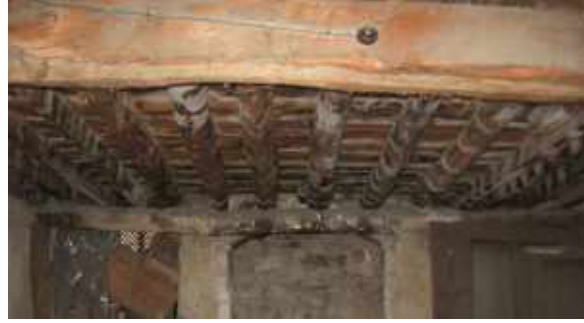
Resim 18. Erdoğan Kalay Evi Ahşap Kirişli Döşeme Sistemi
