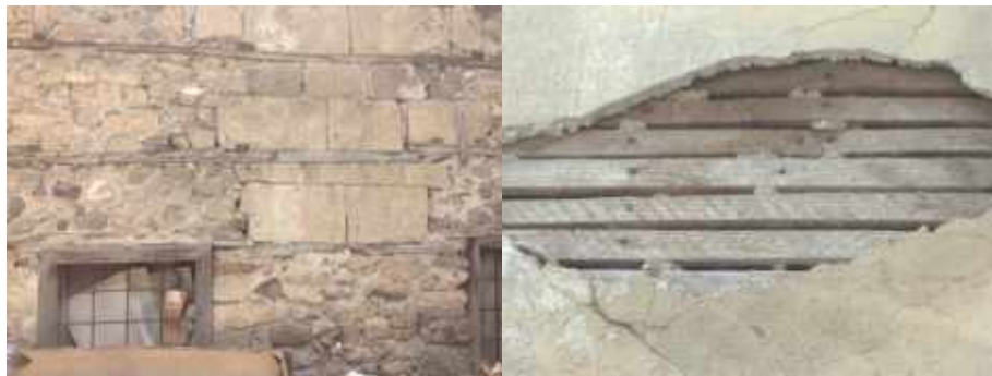
Resim 17. Erdoğan Kalay Evi Taş ve Bağdadi Duvar Örgü Sistemi
