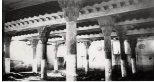
Şekil 10: Ahşap kirişler ve sütun başlıkları. 45
