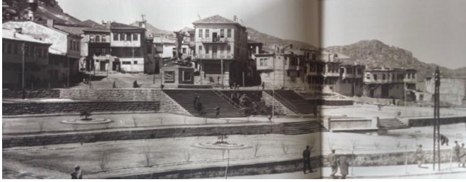
Şekil 20: Umur Bey Külliyesi'nin bulunduğu alanda yapılan park düzenlemesi. 64
