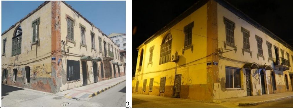
Şekil 14: Eski İngiliz Konsolosluk Binası Batı ve Güney Cephesi köşesi 14.1. Yazar tarafından çekilmiştir, 2025, 14.2: Fahreddin Osmanca kişisel arşivi, 2021-2022.
