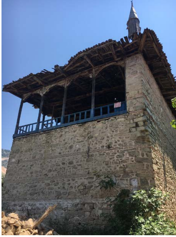
R. 15. Kasımlar Ky Camii Galeri Cephesi (Restorasyon ncesi)
