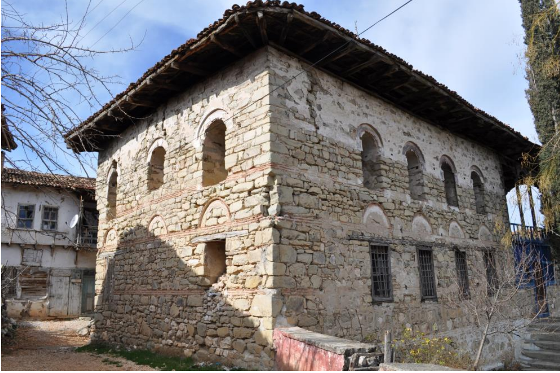
R. 11. Kasımlar Köyü Camii güneydoğu köşe (Restorasyon öncesi) (Foto: Esra Durmuş)
